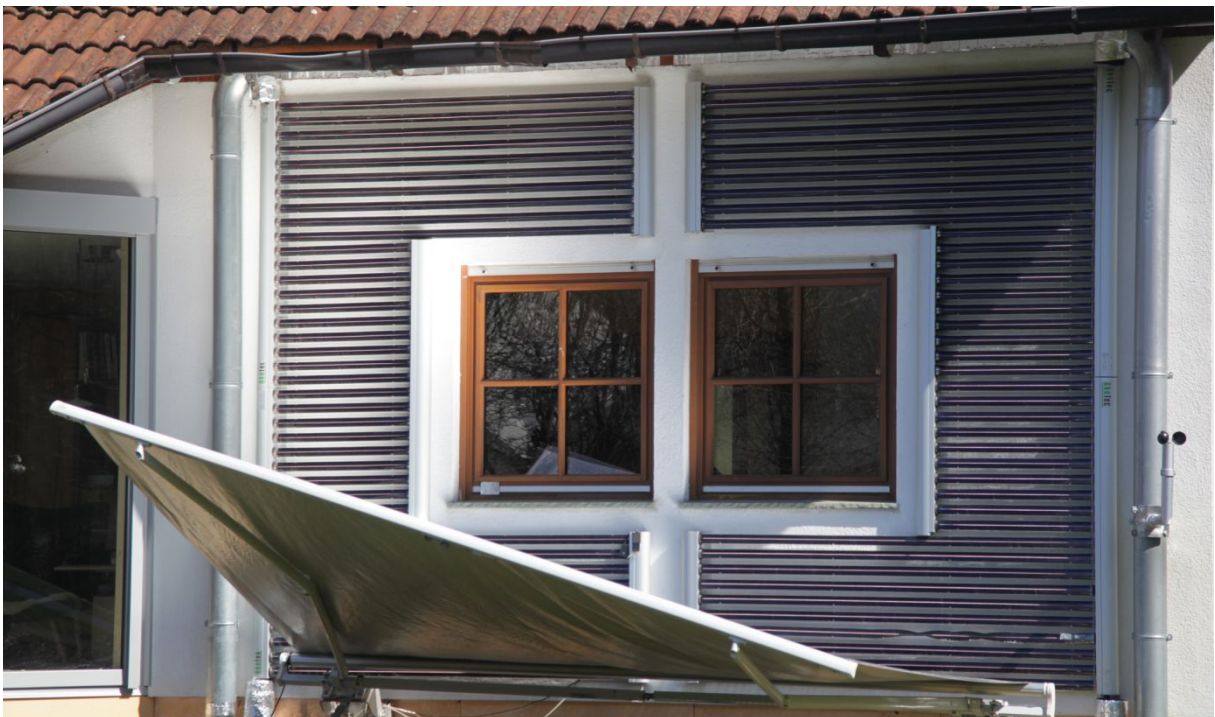
Bild 6: Stahrsolar – Kollektor mit positioniertem Reflektor
